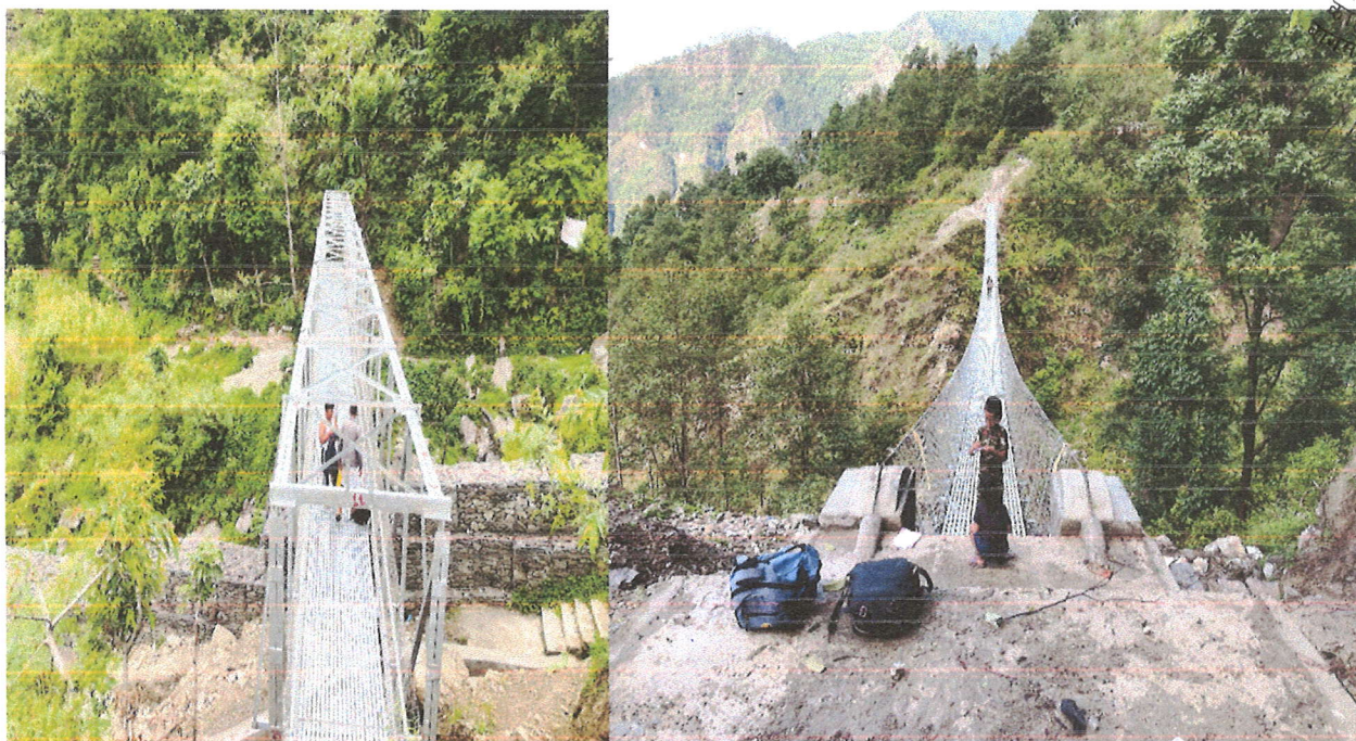
तस्विर: तोर्मे खोला ट्रस पुल किस्पाङ-५ र बुसोंग खोला झो.पु किस्पाङ-१
